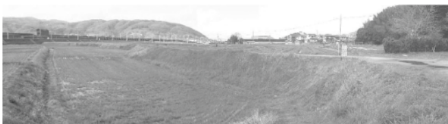
▲この段差が台場南門の部分
