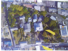
平池家住宅全景(主屋と長屋門)
