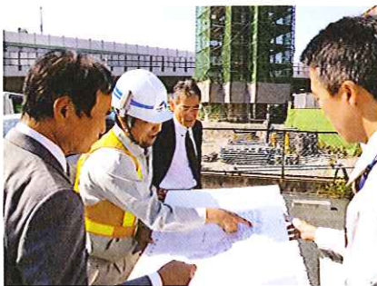
現場の進捗状況、作業工程について説明をうける急ピッチに進む工事現場の様子
