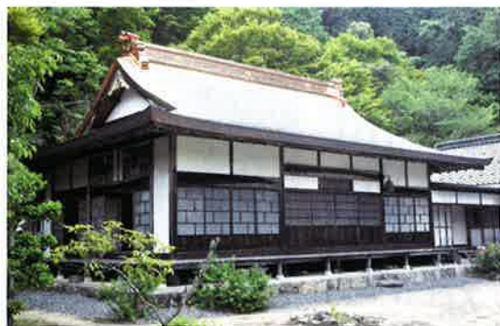
銅板屋根工事の完了した寺
